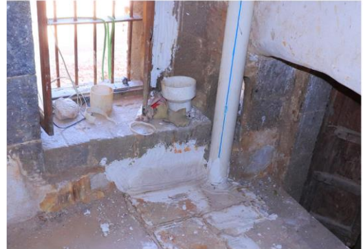
تفقد مواسير الصرف الصحي التالفة للحمامات الداخلية وتنظيف غرفة التفتيش (المجاري)
