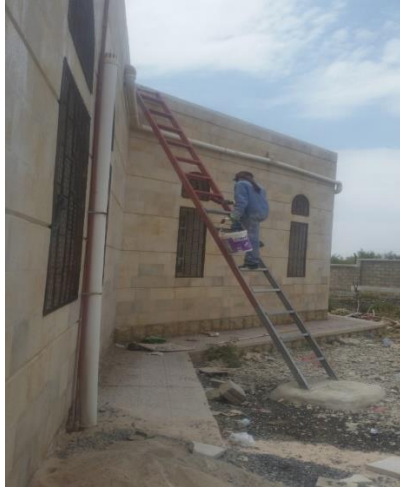
تنفيذ اعمال التثبيت للسلم على قاعدة اسمنتية وعمل الدهانات اللازمة
