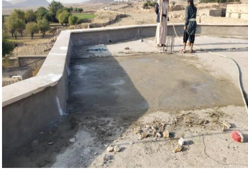
تنفيذ بلاطة صبة خرسانية عادية فوق البلاطة السابقة لسطح المتحف
