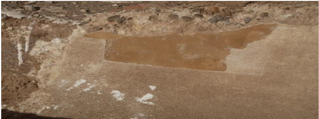
مجس اختباري فوق طبقة قضاض وظهور مادة الخزف على جدران البركة والمطاهر جنوب المدرسة (المصدر: كاميرا الزيارة - عادل سعيد).
