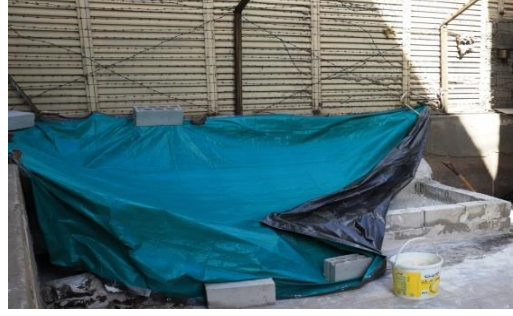
تحضير النورة وعمل الأحواض الخاصة بالتخمير للقضاض ( دق وخلط وتخمير )
