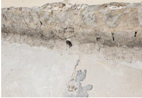
تنفيذ اعمال التكسير لصبة خرسانة الميول للسطح
