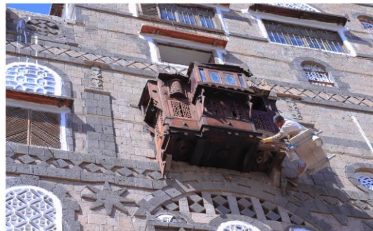
ترميم المشربيات الكبيرة وتنظيفها ودهنها بالزيت
