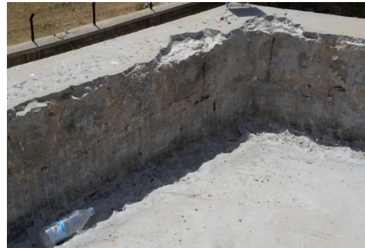
اعمال الشبك الحديد الرابط بين جدار الذروة وصبة خرسانة الميول لسطح المتحف
