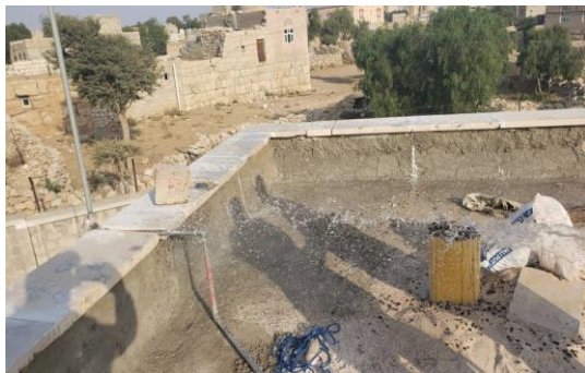
تنفيذ اعمال الطرشة بعد تنفيذ اعمال الخرسانة الرابطة بين الذروة وصبة خرسانة الميول
