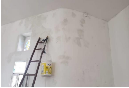
تنفيذ اعمال المعجنة والصنفرة بعد قشط الدهانات المتضررة للجدران الداخلية للمتحف
