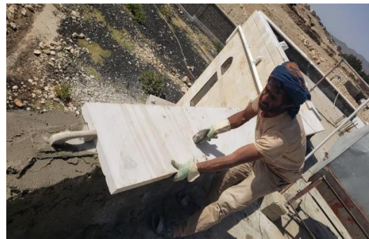
بناء حجر بلق منشار غطاء لسقف ذروة المتحف
