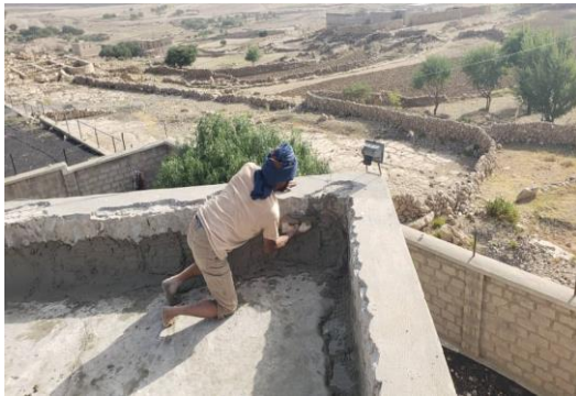
اعمال الخرسانة ( النعلة ) الرابطة بين جدار الذروة وصبة خرسانة الميول لسطح المتحف
