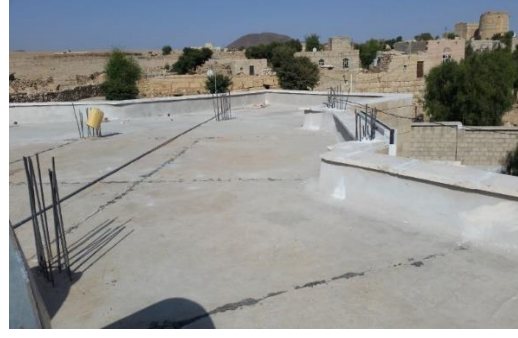
الانتهاء من اعمال التلايس للدروة وصبة خرسانة الميول بعد اعمال الطرشة
